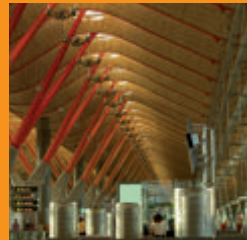
Aéroport International Barajas Madrid
