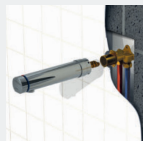
In volle muur met betonsleuf
